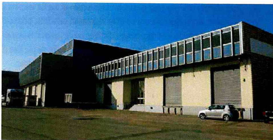
Photo 16 - Aire de chargement et de déchargement
