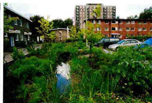
Photo 19 - Gestion des eaux pluviales
