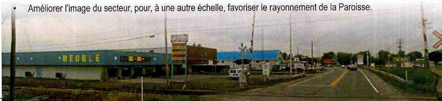
Photo 1 - Entrée de ville de la Paroisse de L'Épiphanie. Source: Google Street View
