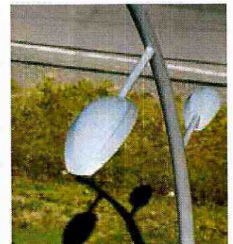
Photo 35 - Exemple de luminaire
