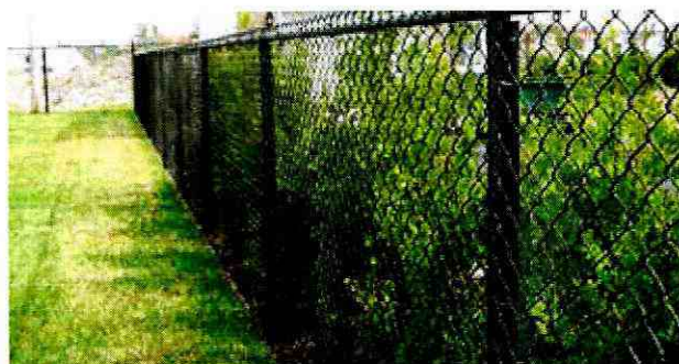
Photo 27 - Exemple de clôture en mailles de chaîne (frost)
